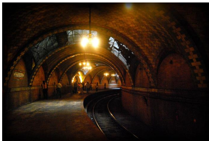
Рис. 5. Станция Сити-холл. Нью-Йорк, США
