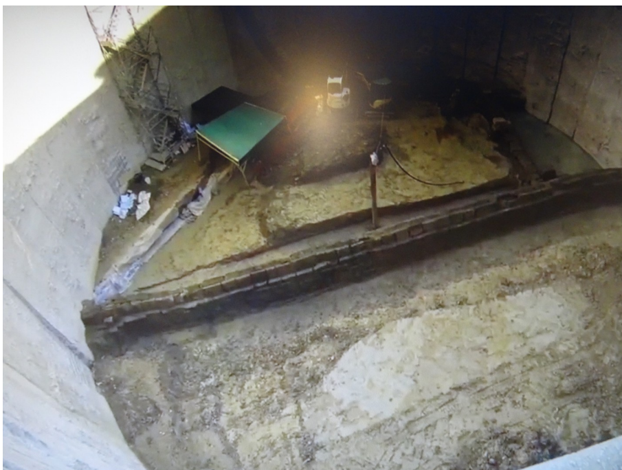
Рис. 28. Участок древнего акведука с ограждением из бетонной стены
