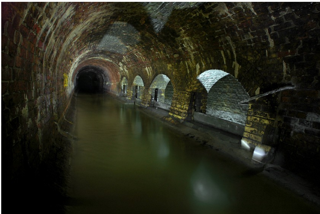
Рис. 25. Канализационный европейский тоннель
