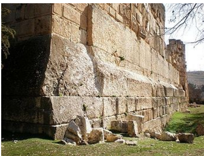
Рис. 15. Три 800-тонных известковых блока в основании храма Юпитера. Ливан
