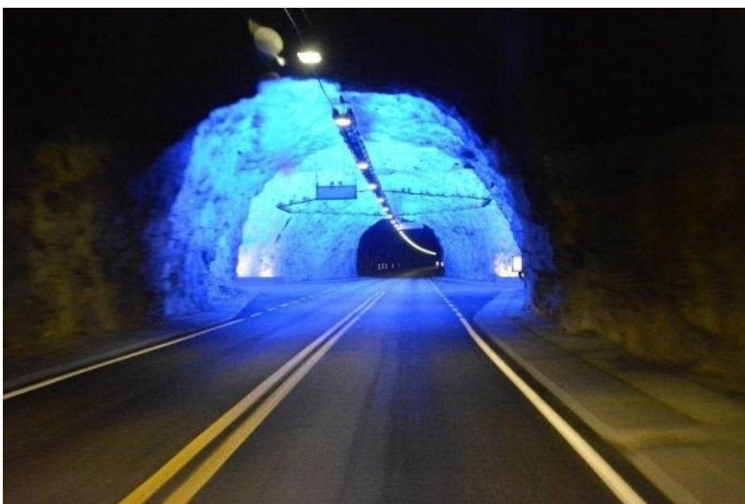
Рис. 29. Тоннели Фарерских островов
