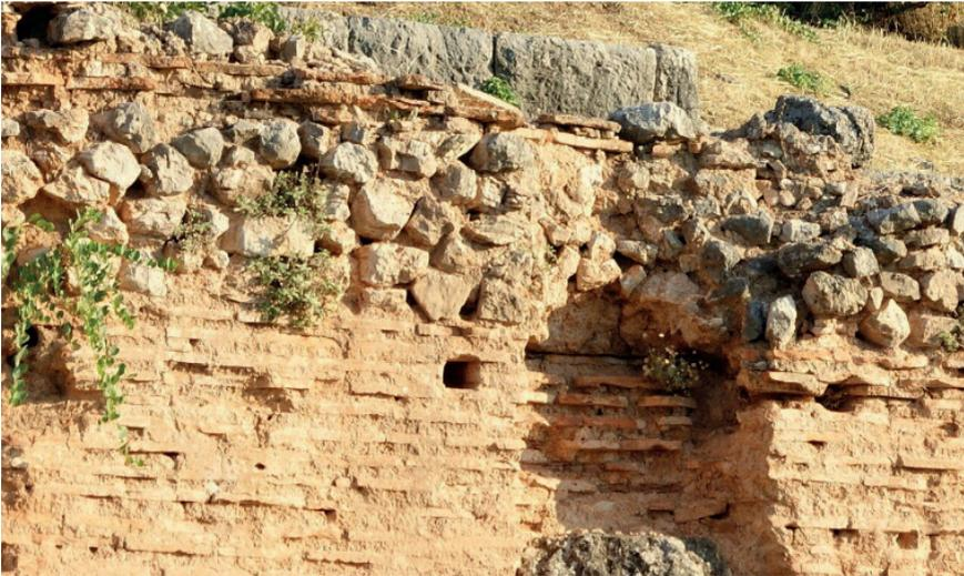
*Рис. 28. Сейсмоизолирующий слой в каменной кладке стены*
