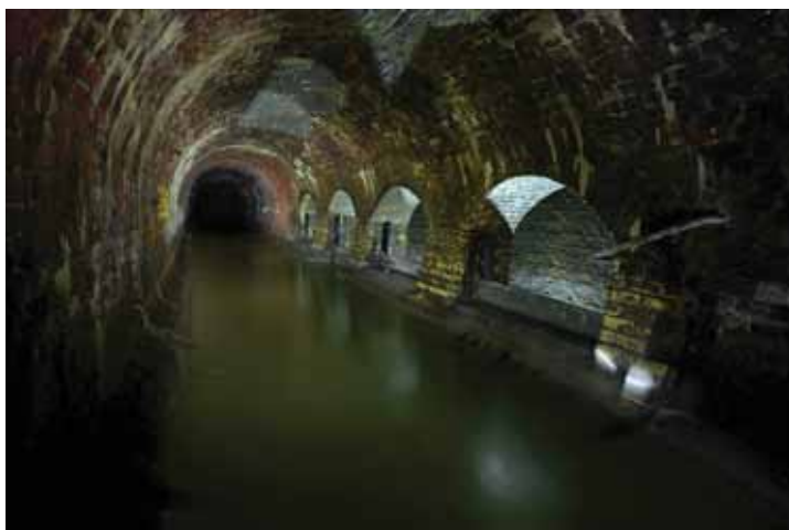
Рис. 143. Канализационный европейский тоннель
