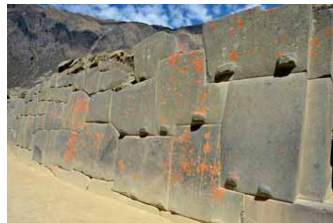
Рис. 256. Незаконченная стена из мегалитической кладки в Ольянтайтамбо. Перу
