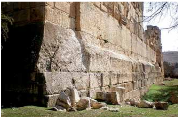
Рис. 133. Три 800-тонных известковых блока в основании храма Юпитера. Ливан
