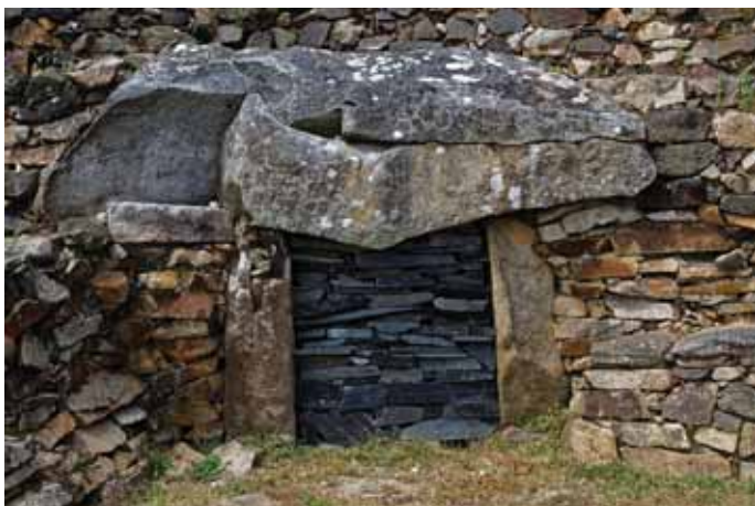
Рис. 77. Использование крупных каменных блоков при устройстве внутренних помещений в кургане Барненес
