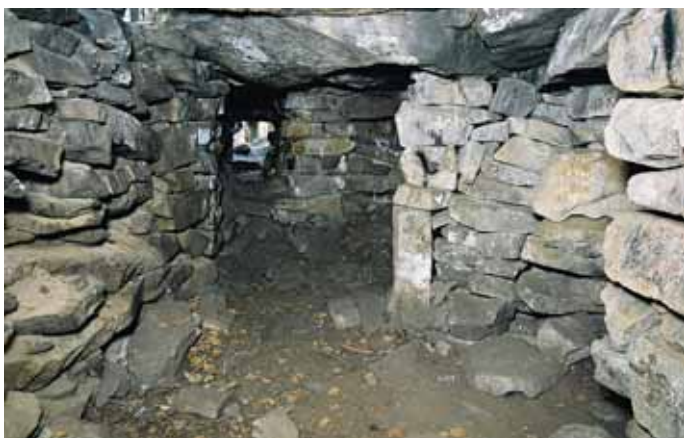
Рис. 81. Вид сооружения внутри
