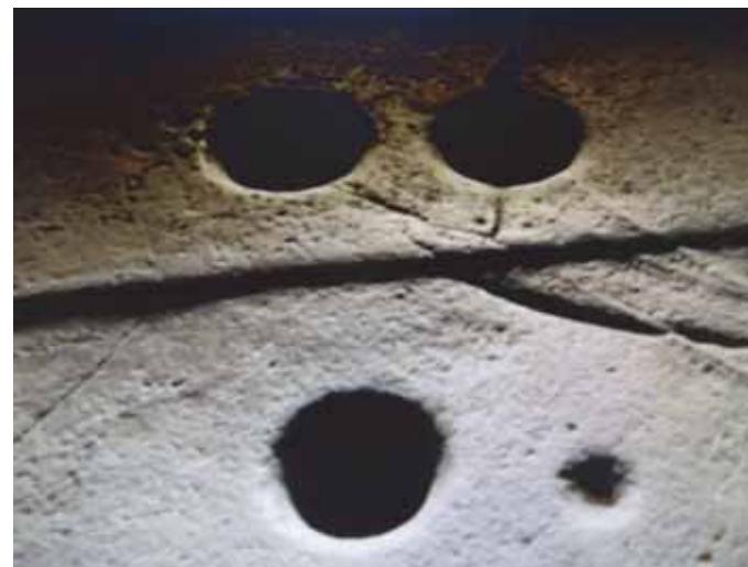
Рис. 104. Отверстия в конструкциях храма
