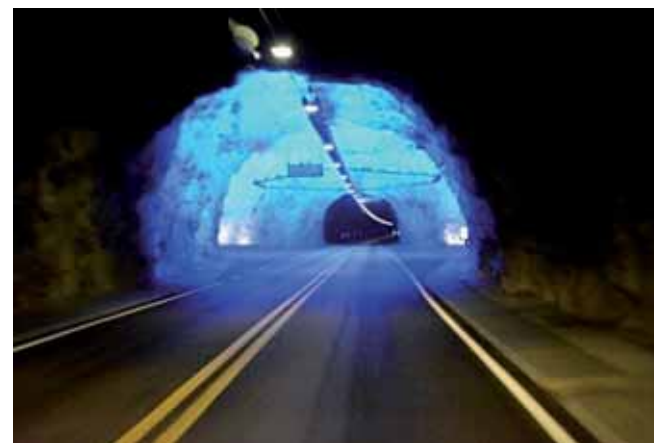
Рис. 147. Тоннели Фарерских островов
