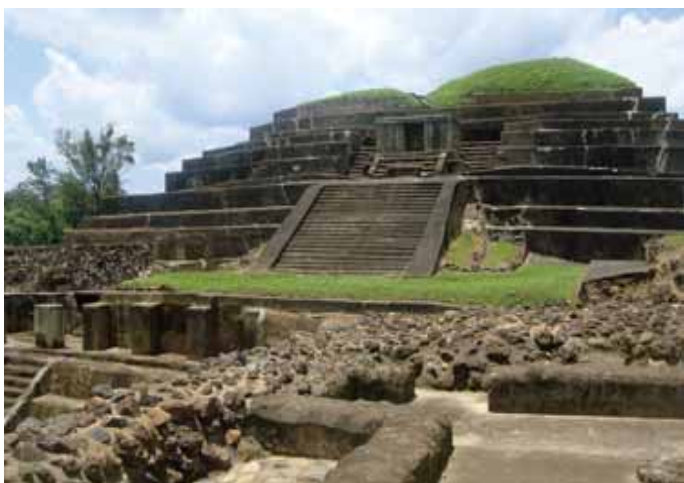
Рис. 164. Пирамидальное сооружение Тасумаль после реставрации
