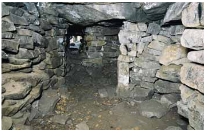
Рис. 81. Вид сооружения внутри
