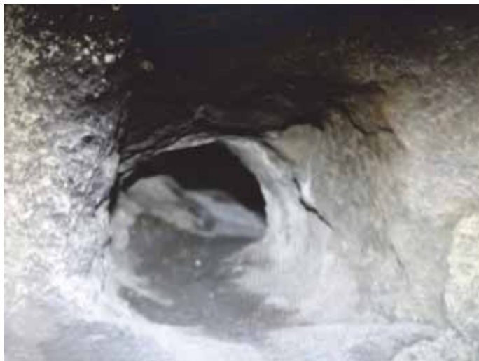
Рис. 103. Частично засыпанный подземный тоннель храма Кайлаш
