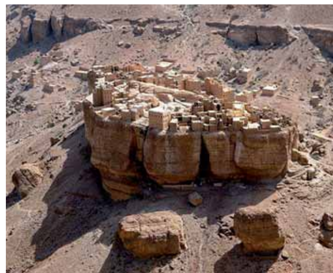
Рис. 200. Строения на столовой горе Хайд Аль-Джазил. Йемен
