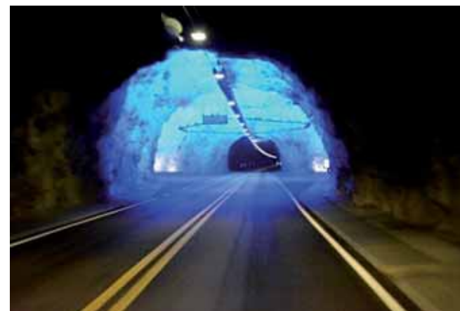
Рис. 147. Тоннели Фарерских островов
