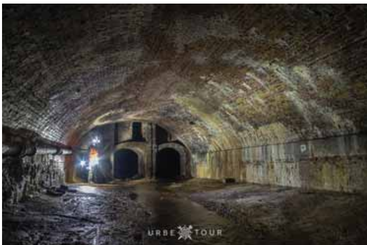
Рис. 144. Канализационный тоннель под Лондоном
