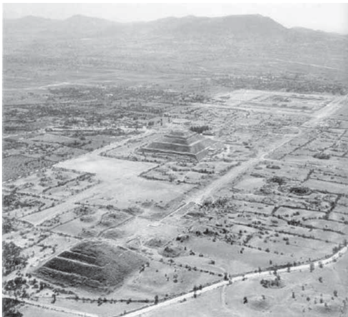
Рис. 150. Центральная часть Теотиуакана до реставрации
