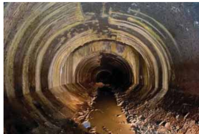
Рис. 185. Древний подземный тоннель
