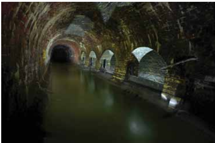
Рис. 143. Канализационный европейский тоннель
