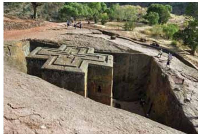
Рис. 108. Сооружение Северной группы города Лалибелы (вид сверху)
