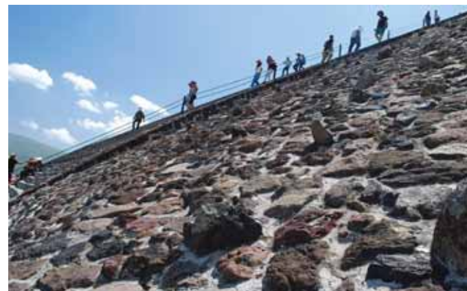
Рис. 154. Использование ломаного камня в пирамиде Солнца
