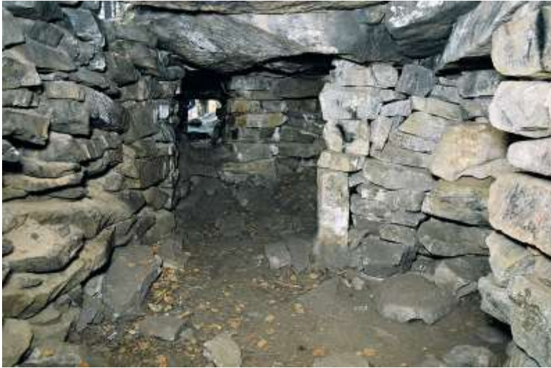
Рис. 15. Вид сооружения внутри
