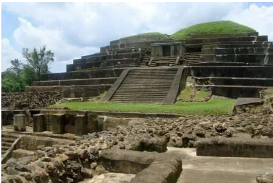
Рис. 15. Пирамидальное сооружение Тасумаль после реставрации
