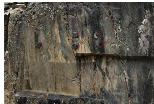
Рис. 136. Предварительная подготовка выступов на поверхности блоков при их заготовке в карьере
