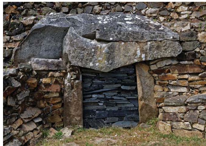
Рис. 150. Использование крупных каменных блоков при устройстве внутренних помещений в кургане Барненес
