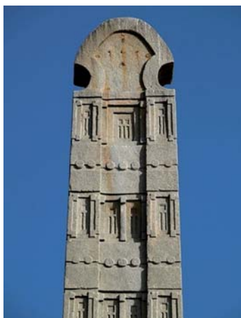
Рис. 81. Отверстия и подтеки коррозии металлических деталей в верхней части стелы
