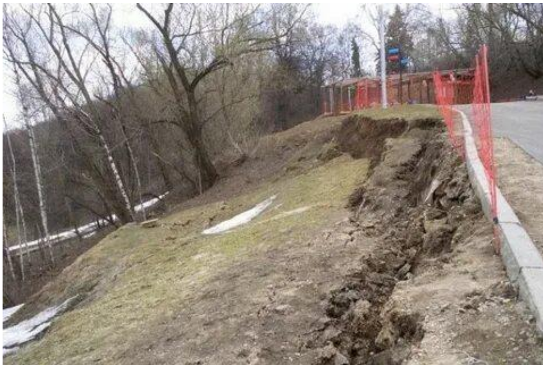
Рис. 2. Оползень грунта и «пьяные» деревья на Воробьевых горах
