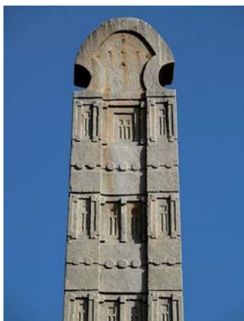
Рис. 81. Отверстия и подтеки коррозии металлических деталей в верхней части стелы
