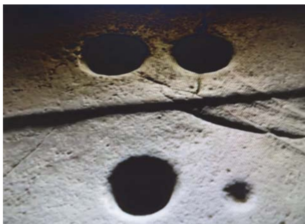
Рис. 173. Отверстия в конструкциях храма
