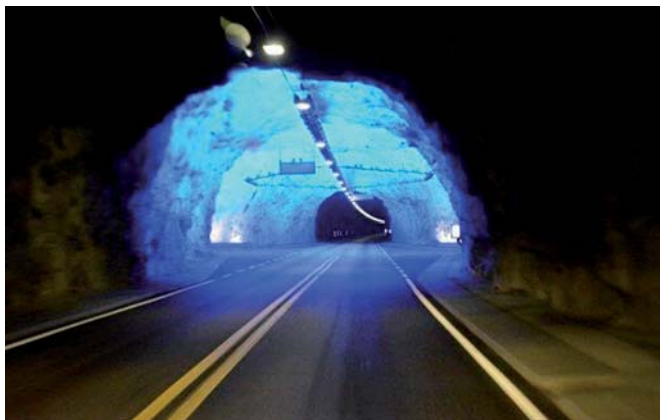
Рис. 218. Тоннели Фарерских островов
