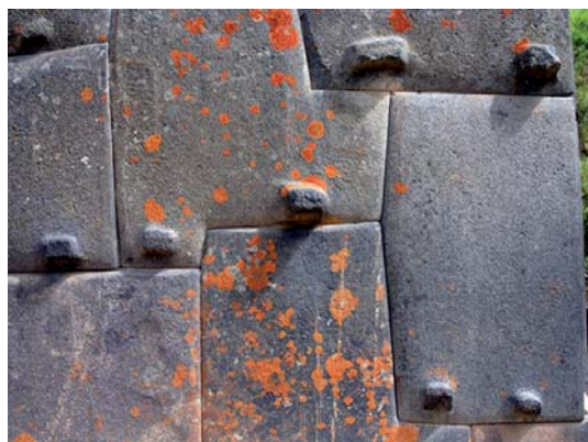
Рис. 137. Блоки недостроенной каменной стены в Ольянтайтамбо. Перу
