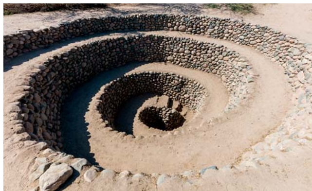
Рис. 28. Спиралевидный колодец со стенками, облицованными камнями
