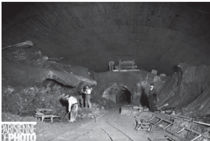
Рис. 213. Расчистка завалов древних подземелий под будущее парижское метро
