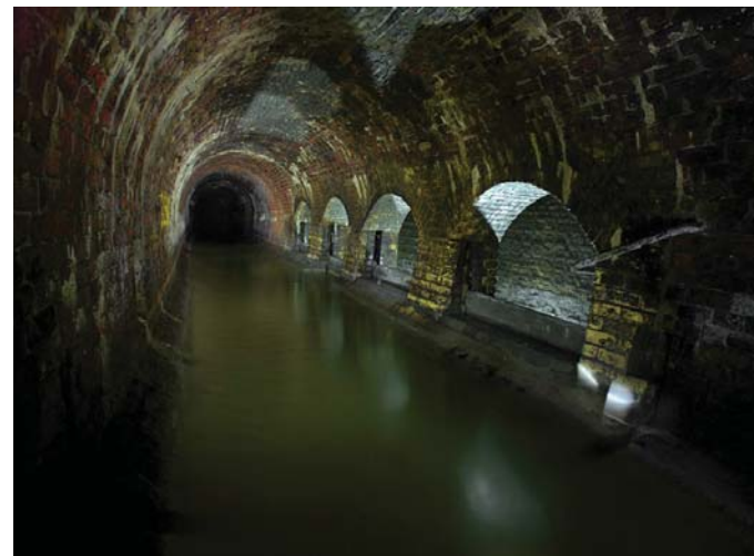
Рис. 214. Канализационный европейский тоннель
