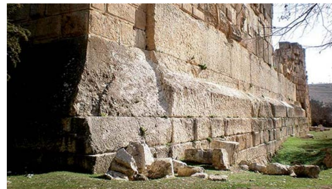
Рис. 198. Три 800-тонных известковых блока в основании храма Юпитера. Ливан
