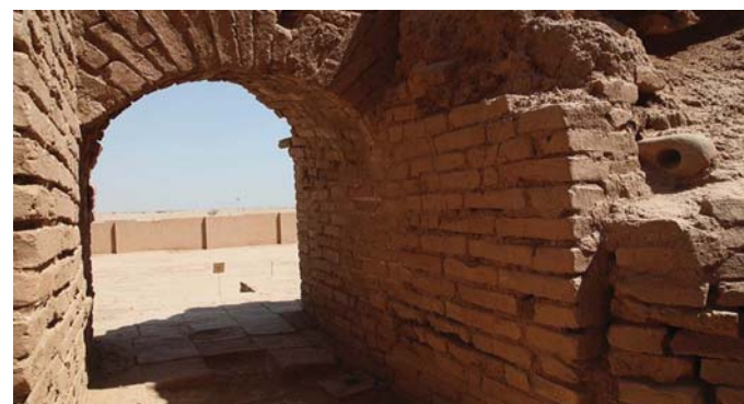
Рис. 272. Пологие кирпичные арки зиккурата городского поселения Чога-Занбиль древнего государства Элам. Провинция Хузестан современного Ирана
