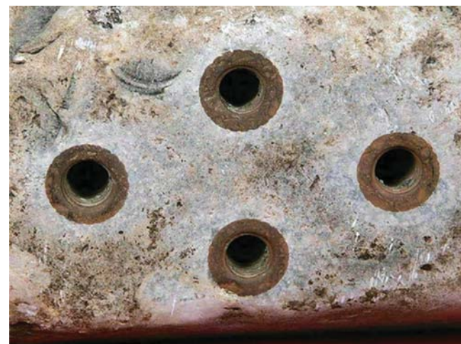
Рис. 80. Отверстия для проводов (выводы) трансформатора
