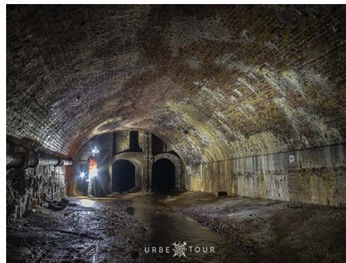
Рис. 215. Канализационный тоннель под Лондоном
