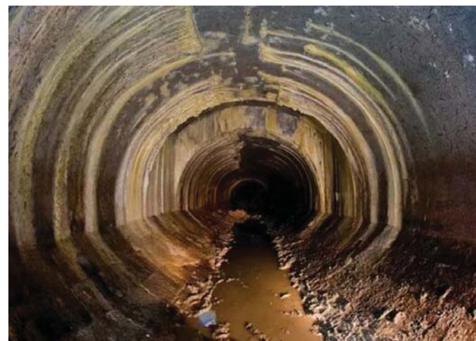
Рис. 100. Древний подземный тоннель
